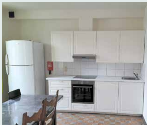
Placement d'une nouvelle cuisine dans une Initiative locale d'Accueil (ILA) à Soheit-Tinlot
