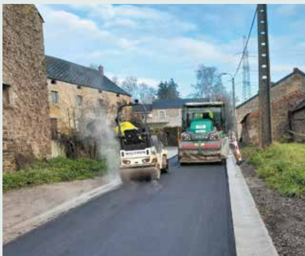
Pose de la sous couche rue Notre Dame au Bois - Fraiture
